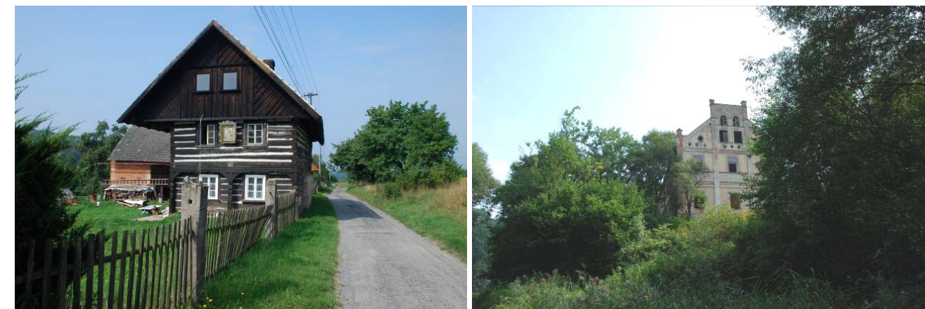
Obr. 2.3.1 a 2.3.2: Panská Ves, Rozprechtice. Roubená usedlost s podstvákou v Panské Vsi a tajupný statek v Rozprechticích jsou příkladem „úryvků“ krajiny spoluvytvářejících její silnou identitu. (Foto: Jana Vorlová)
