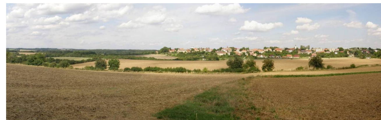
Obr. 3.3.105: Pohled na Nebužely od jihu. (Foto: ATELIER V)
